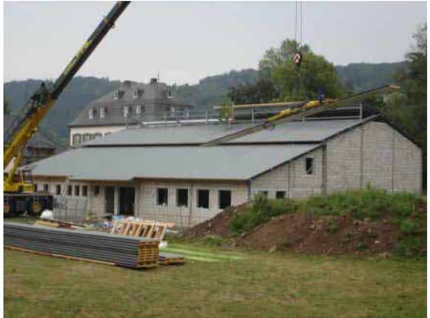
Rohbau der neuen Mehrzweckhalle
